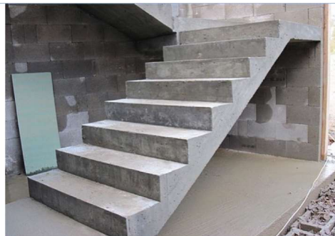
(v) RCC stair
